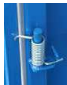
Porta con molla e dispositivo di sbloccaggio
